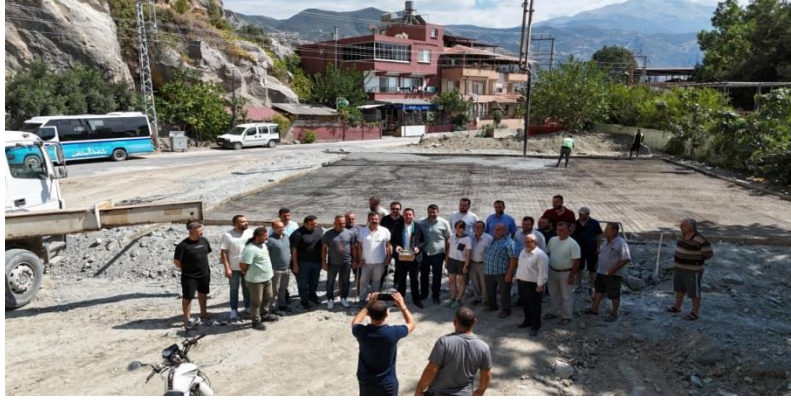
Meydan Mahallesi Çok Amaçlı Salonu Temel Atma Töreni
